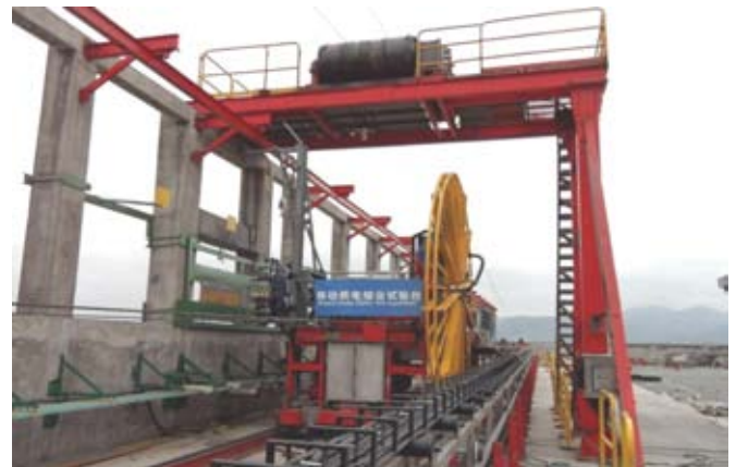
移动供电试验台
