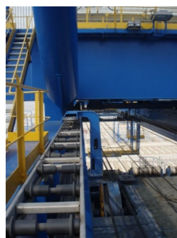
大连岸桥使用现场 Qingdao, QCC's CBCS
